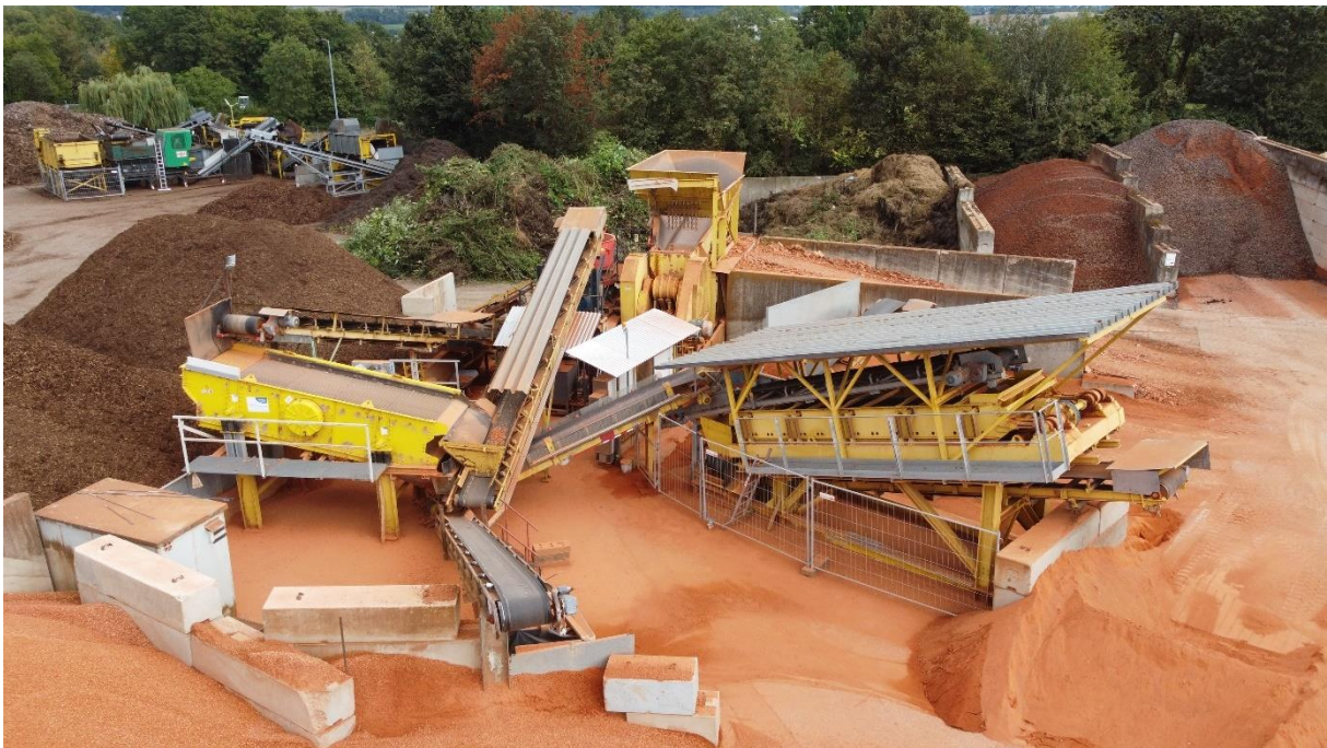
Abbildung 1: Ziegelaufbereitungsanlage bei RETERRA Erden Süd in Remseck
